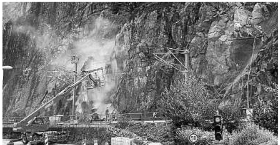
Da die Verhältnisse dort sehr beengt sind und unmittelbar unterhalb der Bahnstrecke die Bundesstraße verläuft, mussten zusätzliche Sicherungselemente aufgebaut werden, welche einen Steinschlag auf die Bundesstraße verhinderten. Mit Ablauf des heutigen Tages werden die Arbeiten dann im gesamten Streckenabschnitt beendet, sodass der Stadtbahnbetrieb morgen wieder aufgenommen wird.
