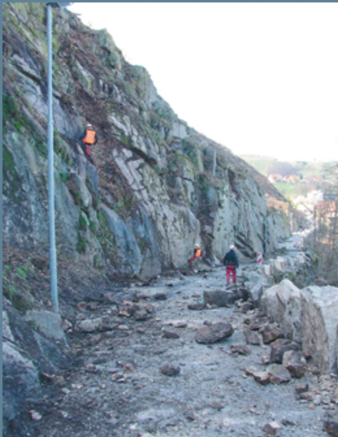
*Die Sicherungsarbeiten entlang der Erlenstraße wurden mit einer Fels- und Böschungsberäumung in den Tagen vor Ostern abgeschlossen.*
