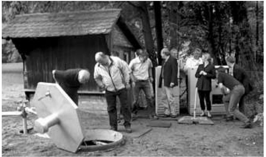
Inbetriebnahme des neuen Pumpwerks „Emisau“
