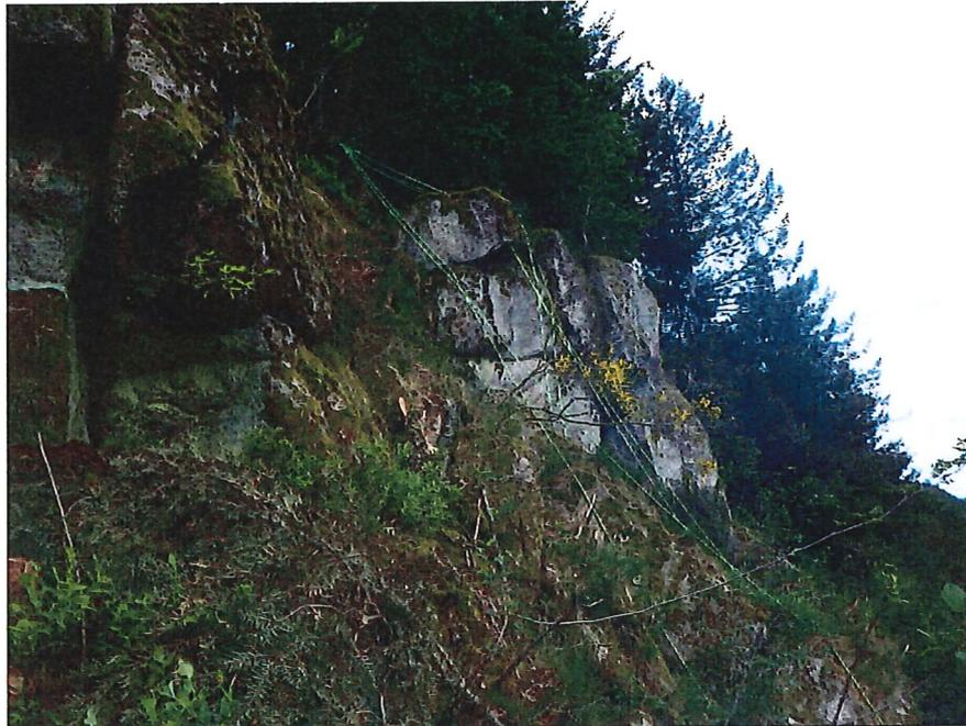
Bereich I: Sicherung mit Spritzbeton, Trossen bzw. einzelnen Nägeln
