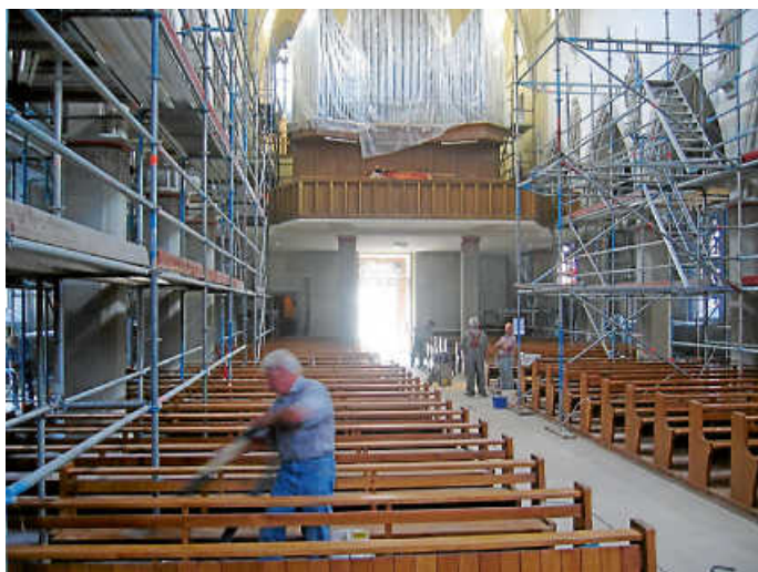
Renovierungsarbeiten St. Wendelin.
