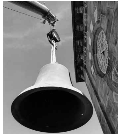
Die Christusglocke wird vom Kran erfasst
