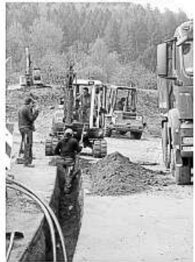
Arbeiten zum Anschluss an das Abwassernetz
