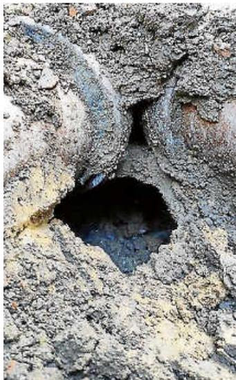
Grundstück verlaufenden Hausanschlussleitung, auch mittels einer TV-Untersuchung, wurde im Ergebnis festgestellt, dass das Abwasser aus dem öffentlichen Kanal austritt und sich hinter dem Gebäude aufstaut bzw. in das Erdgeschoss des Anwesens „Hangstraße 10“ eindringt. Für die Übergangszeit konnte ein Provisorium geschaffen werden, welches das Eindringen des Abwassers ins Gebäude verhindert hat.
