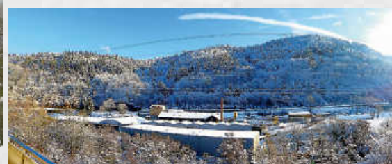
Blick von der Au in die Schlechttau Foto: Fischer A.
