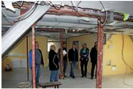
Bauausschuss besichtigt Arbeiten in der Kinderkrippe.
