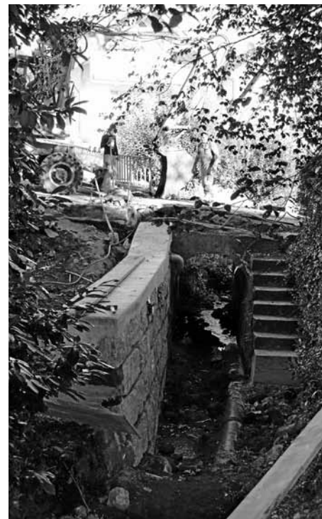
Sanierung der Brücke über den Gaisbach
