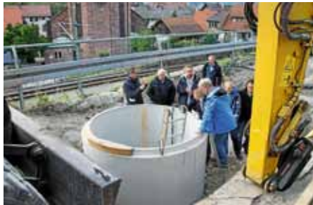
Besichtigung der Baumaßnahme in der Weinbergstraße.
