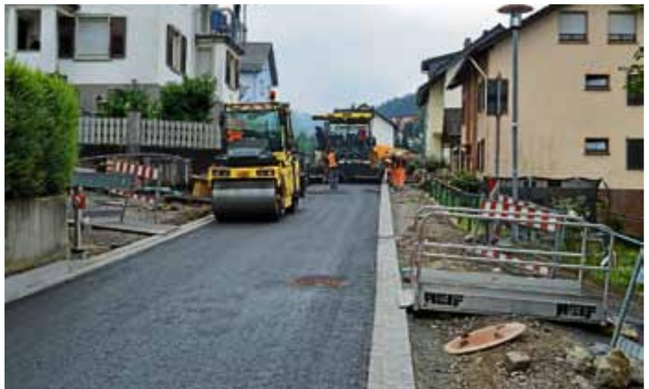
bergstraße müssen Pflaster- und Asphaltarbeiten ebenfalls noch durchgeführt werden. Erst wenn all die Maßnahmen abgeschlossen sind, kann die Asphaltdecke im gesamten Baustellenbereich aufgebracht werden. Angleichungsarbeiten an privaten Hofflächen, Geländerarbeiten an den Mauerscheiben im unteren Bereich der Weinbergstraße oder die Anlegung von Stellplätzen und der Grünflächen sind dann noch weitere Restarbeiten welche anstehen, ehe die Gesamtanierung im September
